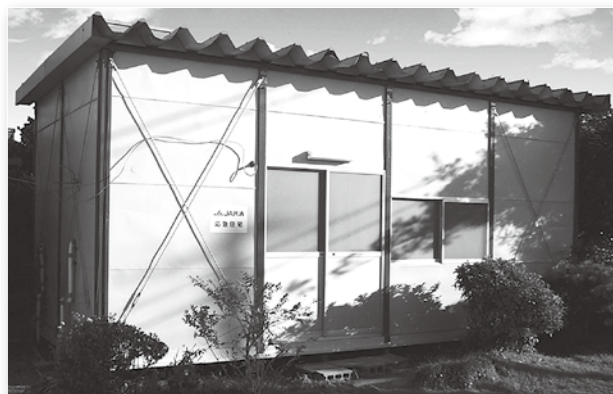
JA共済仮設住宅
